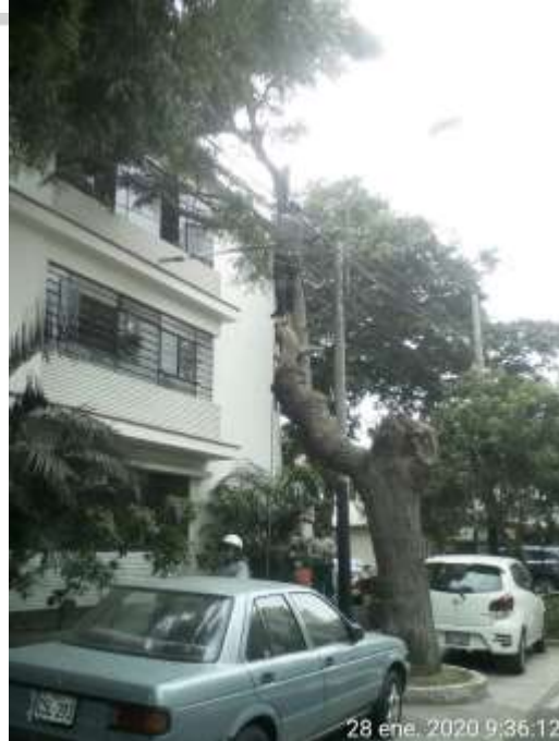
Foto N° 03 Vista lateral del árbol inclinado hacia el predio.
