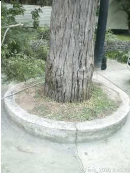
Foto N° 04 Vista de la zona basal del fuste con ligera inclinación, en jardinera circular de espacio pequeño para las dimensiones del árbol.
