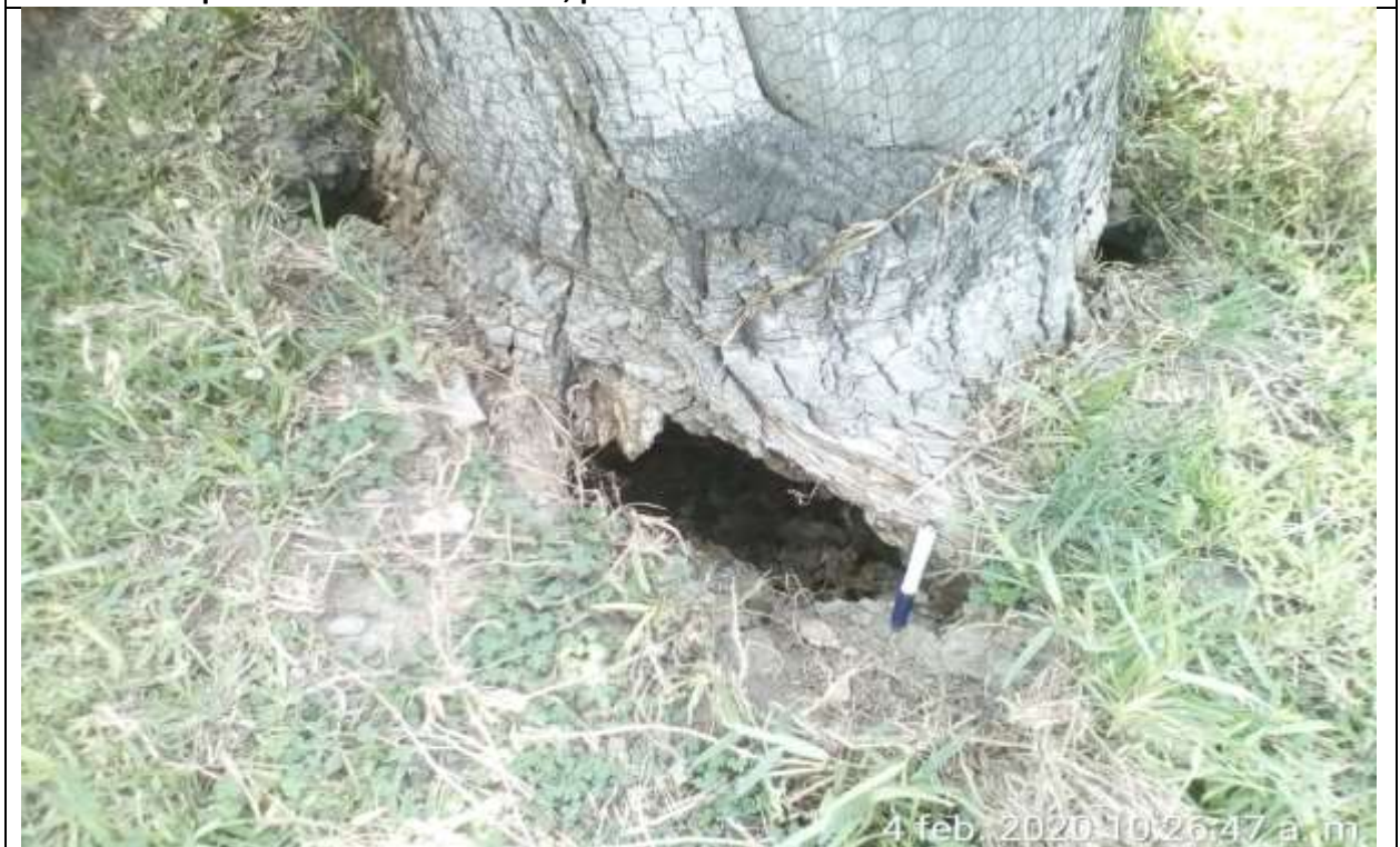
Foto N° 05 Oquedad alrededor de la base del fuste, raíz severamente dañada.
