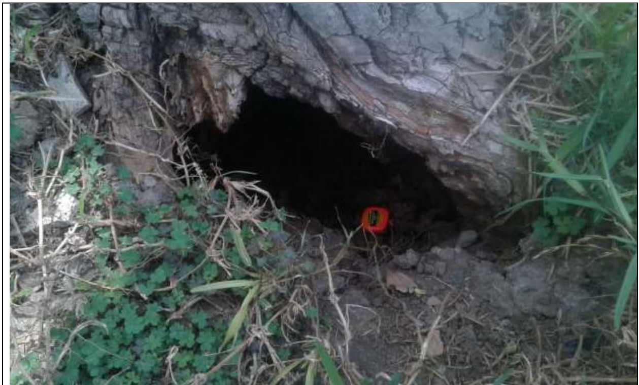
Foto N° 04 Oquedad en la base del fuste, profundidad 50 cm.
