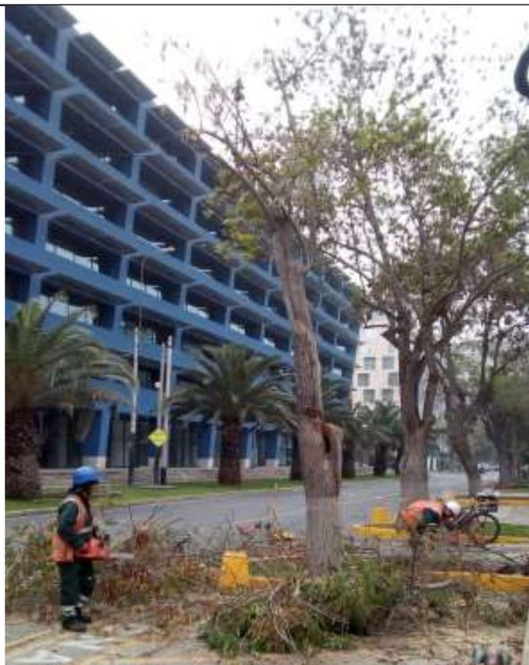
Foto N° 06 Luego de la evaluación del árbol, se retira la rama que tiene dirección de caída a la pista por seguridad.
